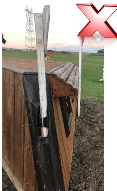
Rossz példa: az elugrás felőli él ugyan lehet, hogy 45°-os, de ez mégis „becsapós” él, ami alatt nincs kitöltő elem, emiatt a ló lába, vagy lábvédője könnyen beakadhat elugrás közben.
